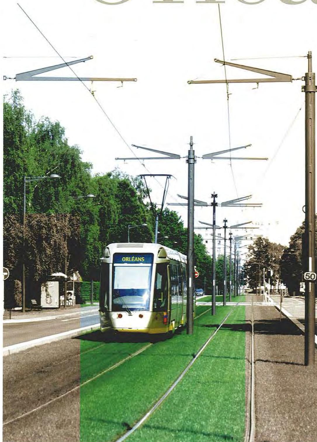
Avec le design de ses mâts supports à profils évidés, surmontés de consoles en "multipinces", le parcours du "Tram" d'Orléans affirme clairement sa technologie, en intégrant, à l'efficacité, une esthétique millimétrée. Le mobilier d'accompagnement, à la fois dépouillé, précis et fluide, casse et arrondi légèrement ses angles. Il balise, informe et invite paisiblement à l'usage, dans une douceur fonctionnelle et une chaleur de la matière toute de simplicité.
