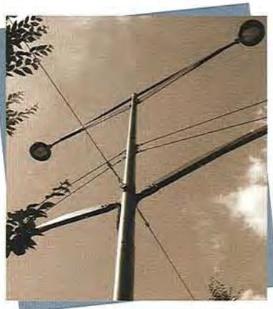
Pour réduire l'encombrement des poteaux support de ligne tout en prenant en compte les contraintes mécaniques spécifiques au site, la fonte à graphite sphéroïdal apporte la bonne réponse.
