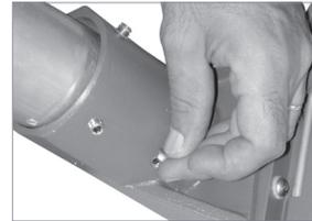
2.4 - Laisser 300 mm de câble dans le luminaire. Dégainer le câble sur 30 mm et dénuder les fils sur 8 mm. Serrer le presse-étoupe (clé hexagonale de 26 mm).
