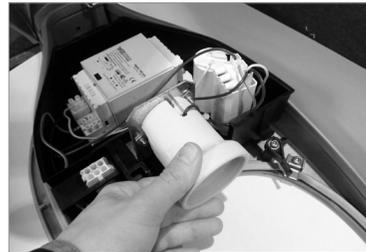
3.4 - Démontez la presse-étoupe et percez l'opercule d'étanchéité.
