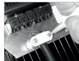
3.2 - Bloquer le câble d'alimentation sur le serre-câble à l'aide d'un tournevis cruciforme
