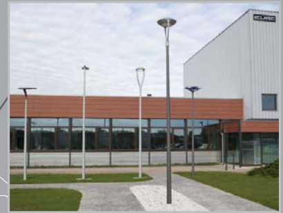
ECLATEC 41 rue Lafayette 54320 Maxéville
