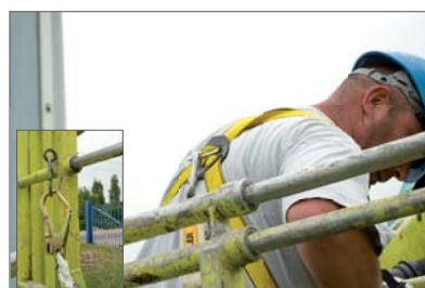
Les personnels, titulaires des CACES et habilitations nécessaires, bénéficient d'un matériel leur permettant de travailler en toute sécurité. Le respect des consignes et normes de sécurité est un souci permanent.
